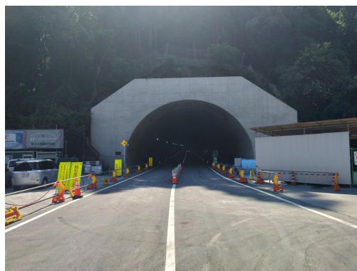
暫定供用された大滝トンネル
